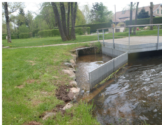
Photo 1 : Seuil réglant le niveau de l'eau dans l'étang du Malsaucy
